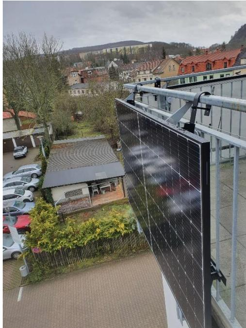
**1. Balkonkraftwerk 600 Watt bestehend aus zwei Modulen Longi 410 W und dem Wechselrichter 600 Watt von Hoymiles (nicht smart, Detail siehe technische Datenblätter)**
